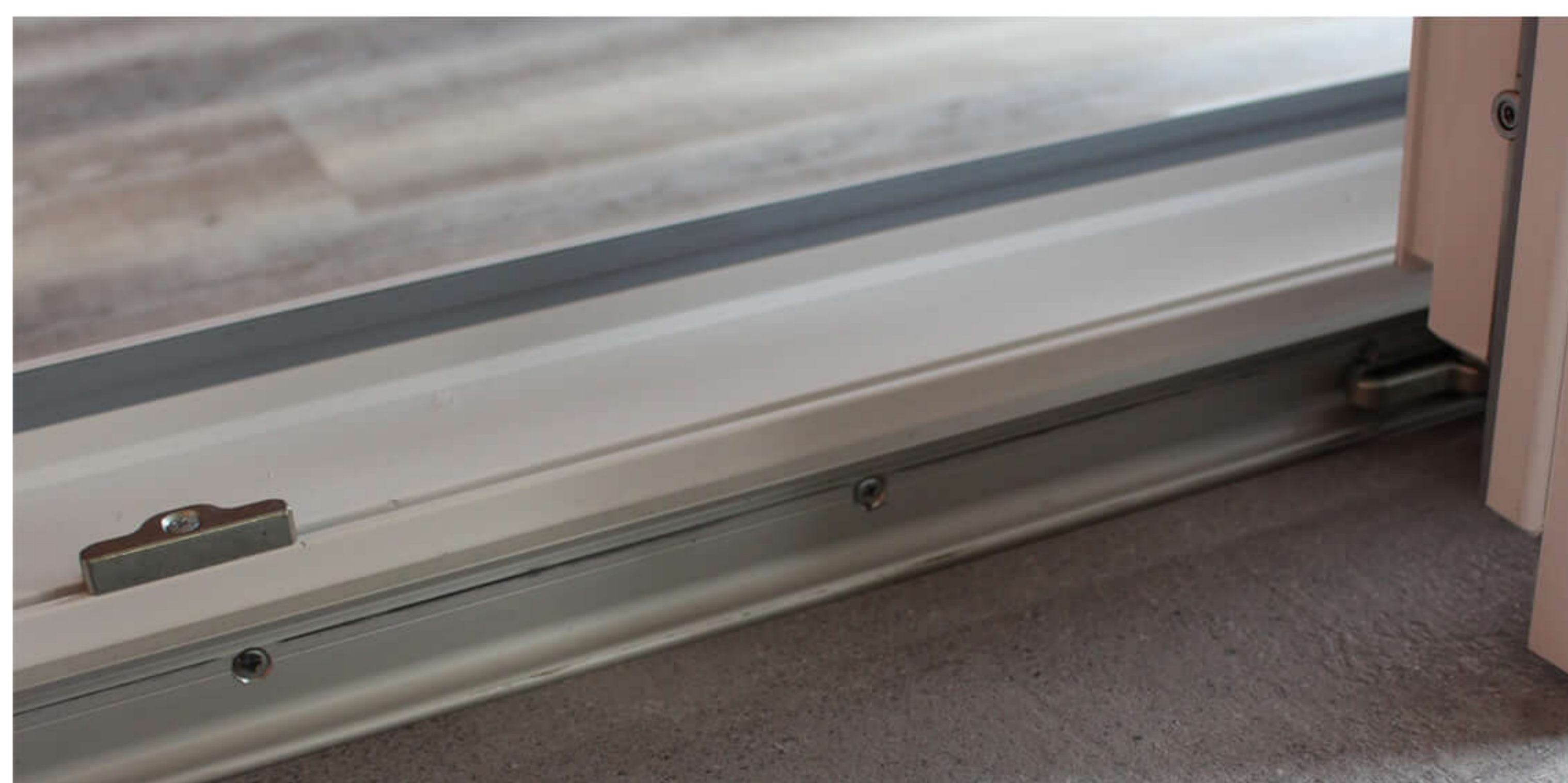
Detailansicht Bodenschwelle Abstell-Schiebetür und PSK-Tür
